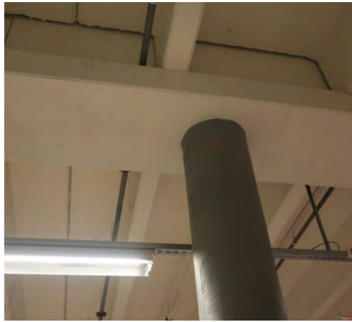
Søyle, betongdekke, bjelker
